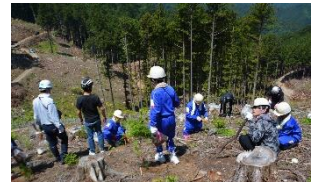
結構な斜面での作業です。
